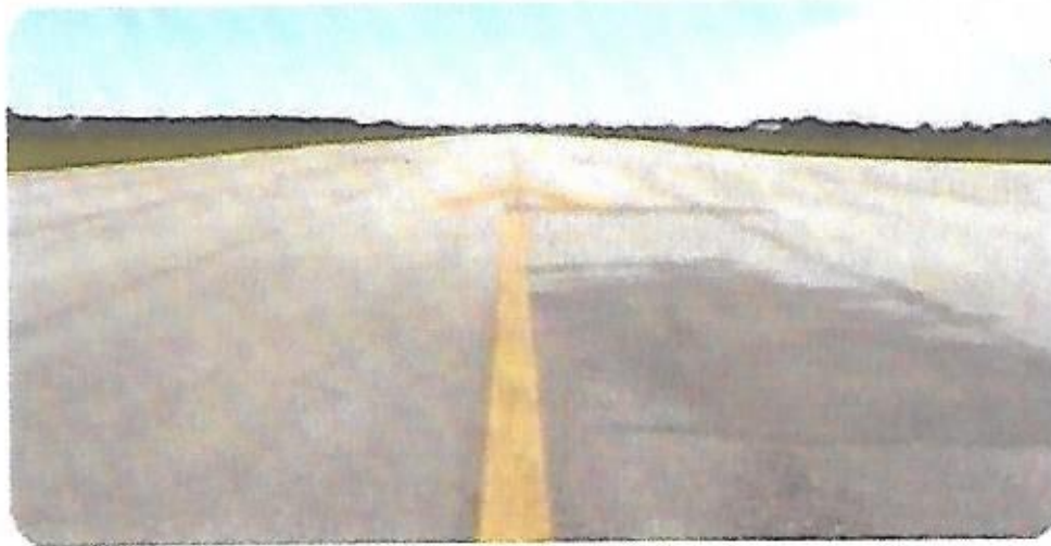
Figura 55 – Pista de pouso e decolagem
