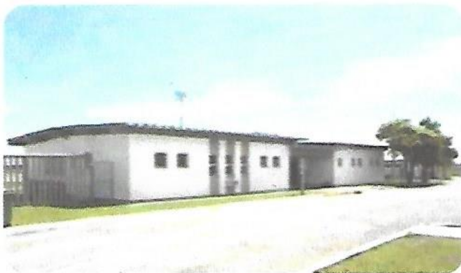
Figura 54 – Terminal de passageiros
