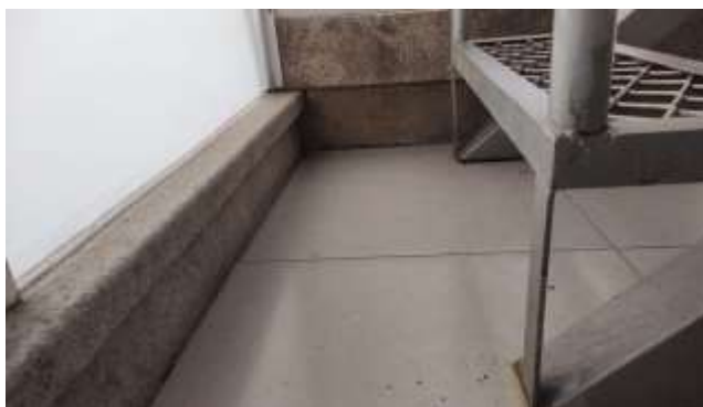
FIGURA 14: FOTO DO ESPAÇO A SER FECHADO COM A EXECUÇÃO DO PATAMAR.
